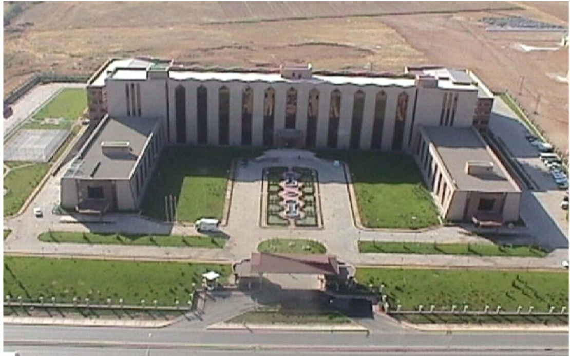
Resim 2- Başkanlık Hizmet Binası (Üstten Görünüm)
